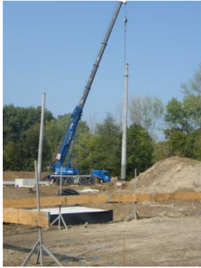
Abb. 15 und 16: Aufrichten der Masten für die vertikale Schrotfangeinrichtung und Teil eines Fundaments
