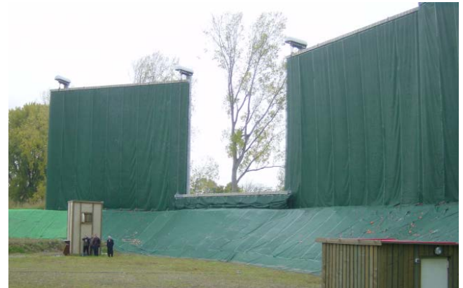
Abb. 14: Kombinierte Trap-Skeet-Anlage mit mehrlagigen Netzen
