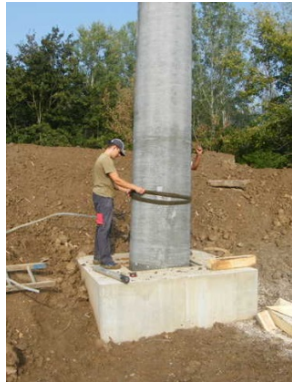
Abb. 15 und 16: Aufrichten der Masten für die vertikale Schrotfangeinrichtung und Teil eines Fundaments
